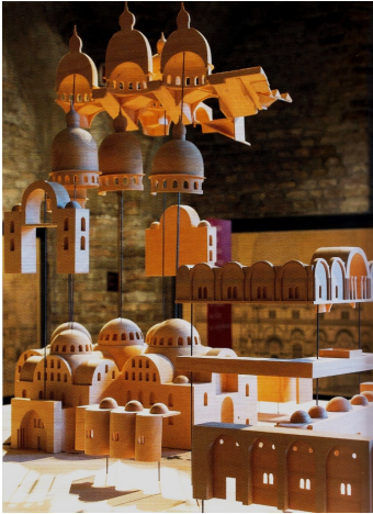
2 | Modello 'esplosivo' delle fasi costruttive della Basilica di San Marco conservato nel Museo marciano.
